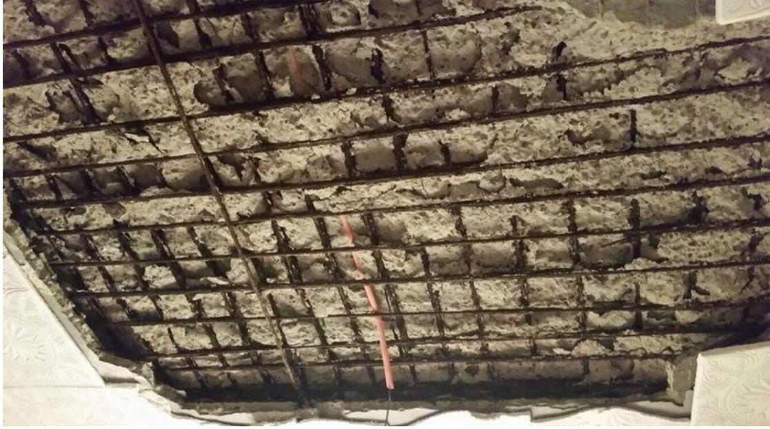
ينمو الصدأ ويزداد حول حديد التسليح منتجاً شروخاً بامتداد طولها. وقد يؤدي ذلك إلى سقوط الخرسانة كاشفة حديد التسليح وتساعد كلوريدات الكالسيوم الموجودة في الخرسانة على ظهور هذا العيب كما تساعد على ذلك الرطوبة المشبعة بالأملاح في المناطق الساحلية تحمل كلوريد الكالسيوم، وبالتالي فإن خطورة تآكل الحديد تصبح كبيرة في هذه الحالة. إن شروخ تآكل الحديد خطيرة على عمر المنشأ وتحمله حيث تقلل مساحة الحديد في القطاع الخرساني، وهذه الظاهرة خطيرة بصفة خاصة في الخرسانة مسبقة الإجهاد.
